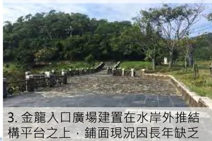
3. 金龍入口廣場建置在水岸外推結構平台之上，鋪面現況因長年缺乏維護，部分地磚破損及脫落
